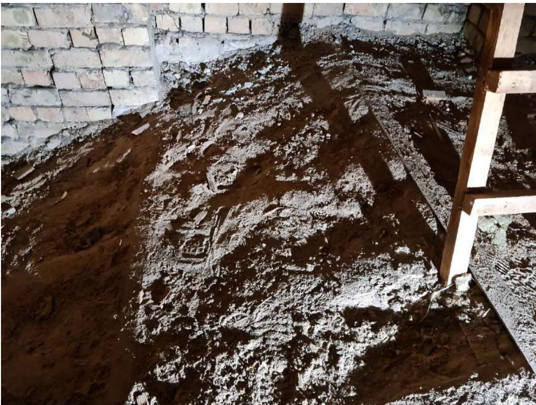
134239 - perdanga virš laiptinės, iš viršaus užpilta šlako ir smėlio mišiniu, metalo profiliai neapsaugoti nuo korozijos, parūdiję.
